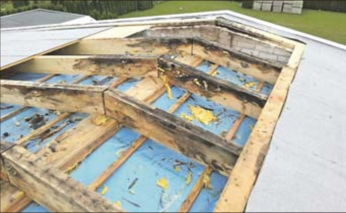
Feuchteschäden am Dach und seiner Dämmung können teure Renovierungsarbeiten erforderlich machen.
